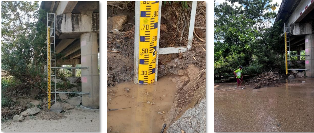
รูปที่ 5.2.1-3 การติดตั้งแผ่นวัดระดับน้ำ (Staff Guage)
